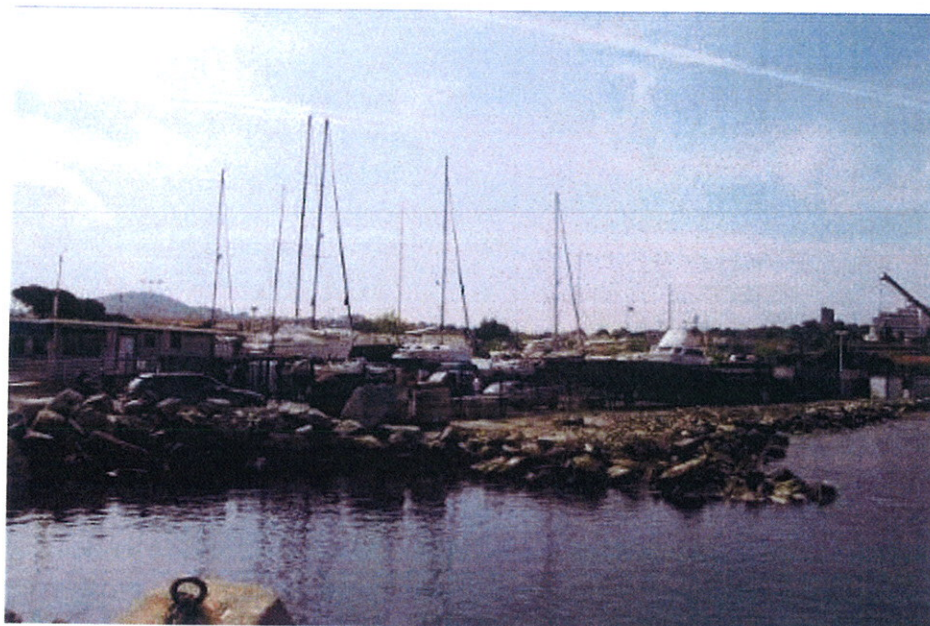
Vue d'ensemble de la zone technique
